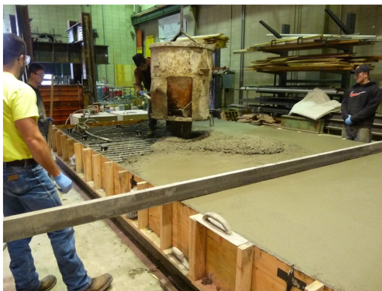
Figure 4.12 Bridge deck concrete pour
